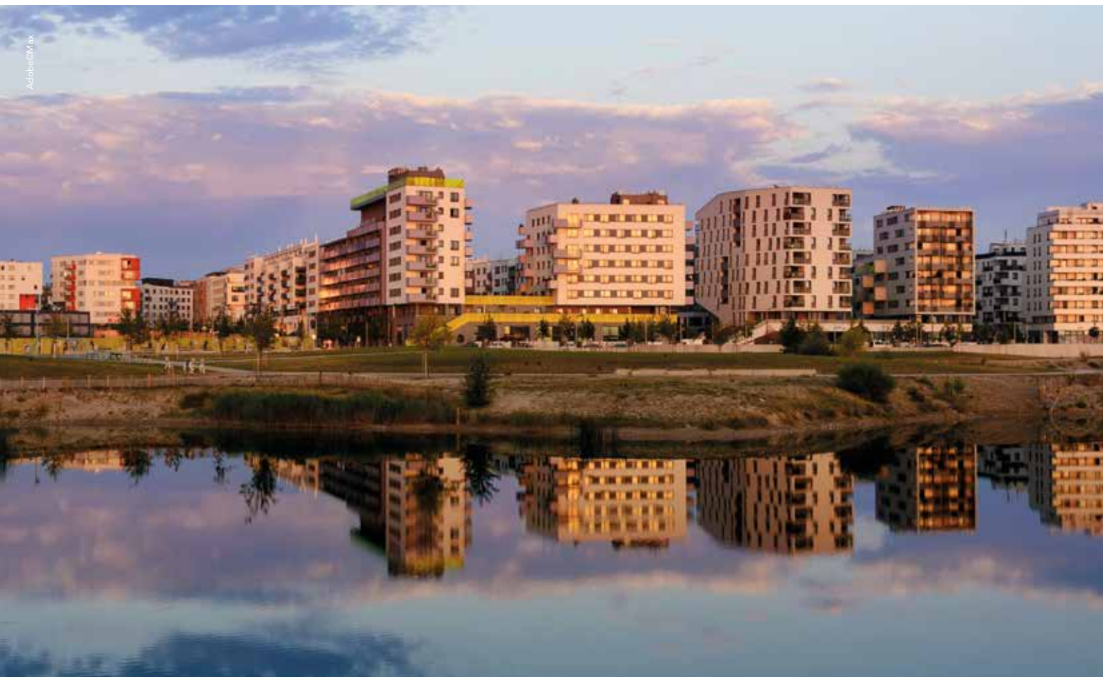
ABBILDUNG 6-3: STADTQUARTIER SEESTADT ASPERN
